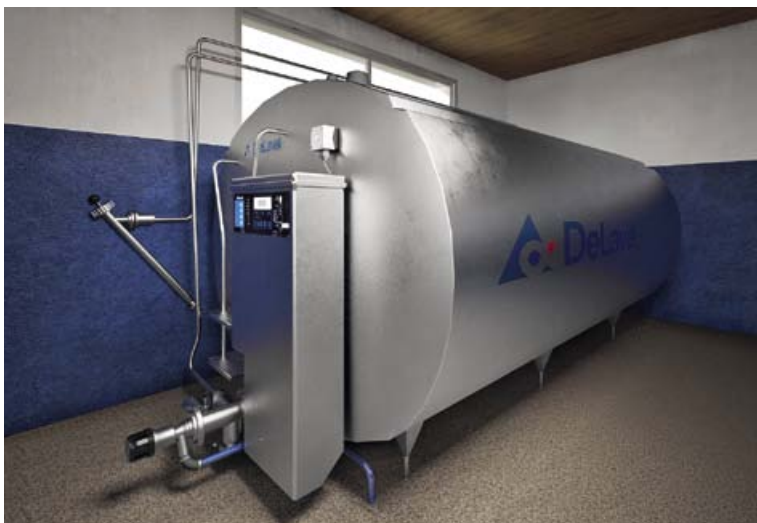
Das Milchzimmer ist mit einem kompakten Kühltank von 4'500 Liter Inhalt ausgestattet.
